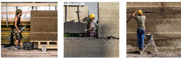
Ricola Kräuterzentrum, construcción de muros de tierra Construction of rammed earth walls
